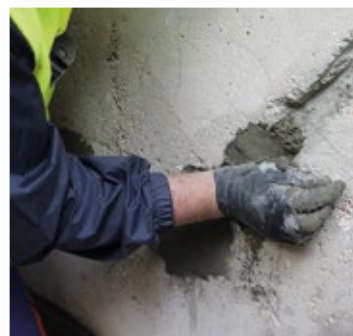
Εφαρμογή PENECRETE MORTAR®
